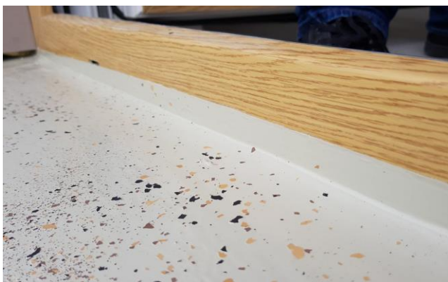
Doszczelnienie styku posadzka - okno balkonowe
