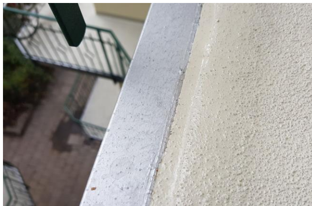
Doszczelnienie styku posadzka - obróbka blacharska
