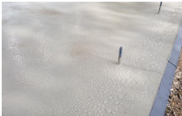
Doszczelnienie szpilek pod mocowanie balustrad
